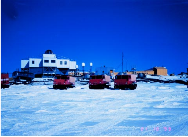
写真2 全体画面-海水から管理棟を見、雪上車が海氷上に有る
